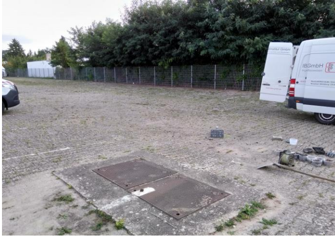
Bild 7: Tankdomschachtbereich mit im Grundwasserabstrom zum Tank abgeteufem Erkundungspunkt RKS/RP 4 im Blick aus W.
