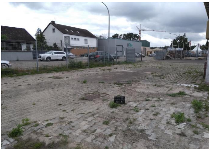
Bild 11: Blick aus O auf den Benzinabscheider mit dem direkt NO daneben abgeteuften Erkundungspunkt RKS 6 (Im Hintergrund: Grundfläche der ehem. Zapfinsel).
