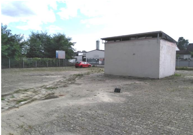
Bild 3: Der im erweiterten Grundwasserabstrom abgeteufte Erkundungspunkt RKS/RP 2 im Blick aus NO.
