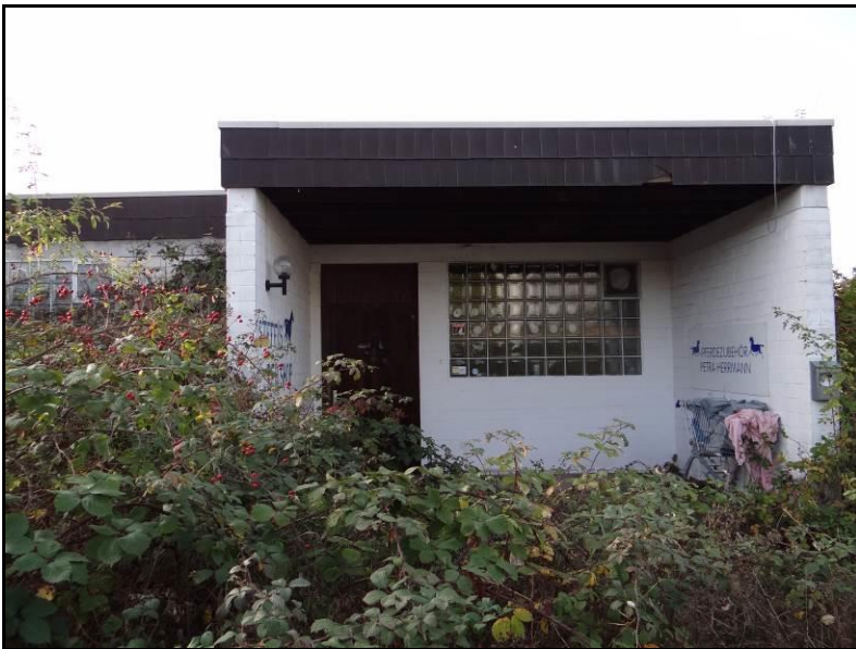
Abb. 12: Ungenutztes Gebäude im NW des Flurstücks Nr. 11508/ 50.
